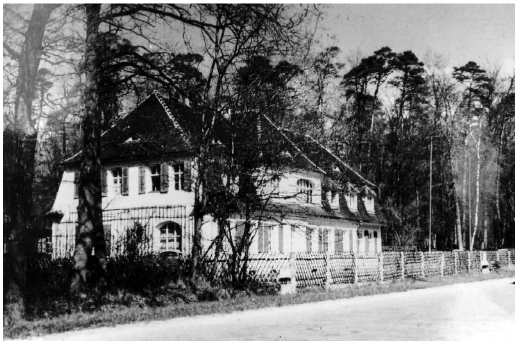
Abb. 1./1: Hauptgebäude des Staatlichen Forstwirtschaftsbetriebes Bitterfeld/Dübener Heide in Tornau-Eisenhammer um 1952. Foto: Max Sündermann (1920-2011), Tornau.
