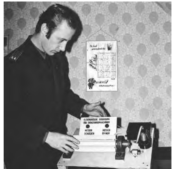
Abb. 1/14: Revierförster HEINZ FAHNER, StFB Kyritz, entwickelte eine elektronische Steuerung für die Entastungsmaschine EA 60, die in die Serienfertigung des Kombinat Forsttechnik überführt wurde (Archiv RÖMPLER)
