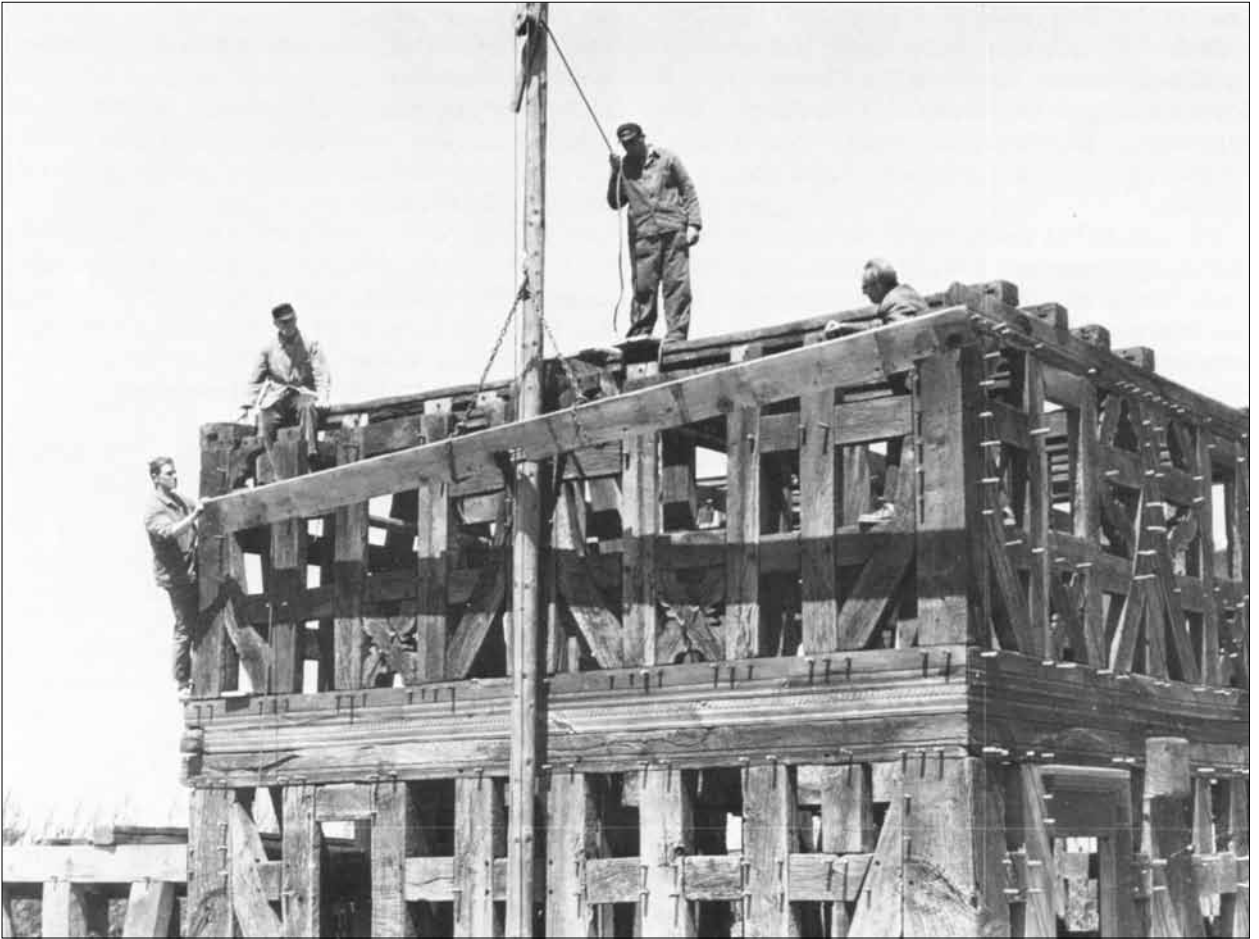
Holzverbrauch für den Hausbau: Aufbau eines Fachwerkhouses aus Bilkheim (Westerwald)
